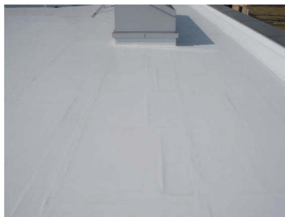
断熱材の段差
