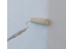
仕上げ材施工
