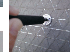
アンカーピン打込み
