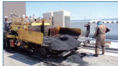
■アスファルト舗装
