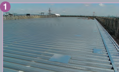
1 波型デッキ敷設
