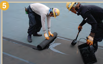
5 防水層の施工(平場2層目)
