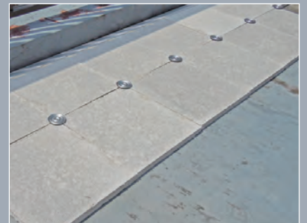
3 センター金物取り付け
