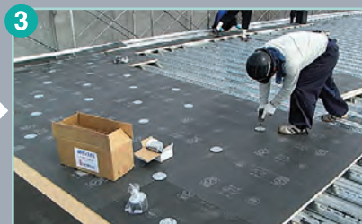
3 断熱材ディスク板留め
