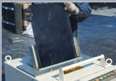
アスファルト投入
