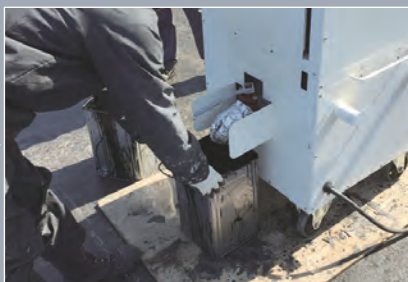
アスファルト排出
