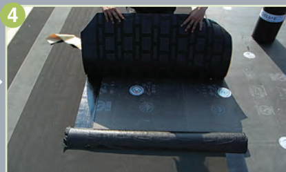
4 防水層の施工(平場1層目)
