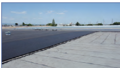
■アスファルト舗装完了
