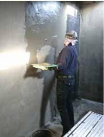
サンエーシートを標準施工しモルタルを 10mm 打設、7 日間養生後、引張接着強度試験を実施
