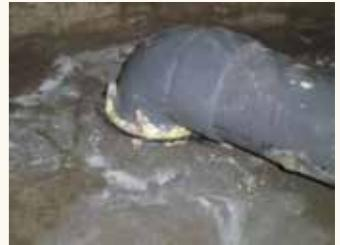
床から直接エルボ継手設置は避ける
