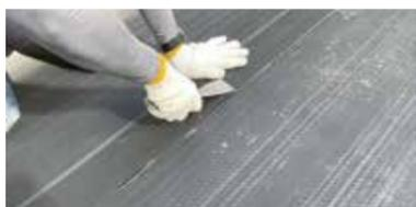
浮かし張り(サンエーボンドPUによる接合)
