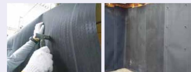
サンエーボンド PU 塗布&セパ用パッチ取付け
