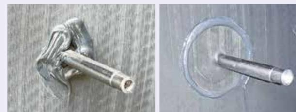
接合部サンエーボンドPU塗布&接合 (50mm幅)
