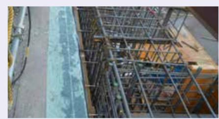
天端コンクリートにサンエーシートを張り掛け後、養生をしている状態
