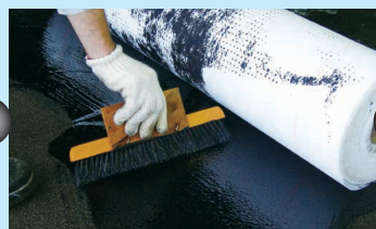
●ハルPCマットの流し張り
