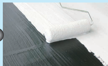
●保護層の施工
