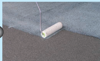
●プライマーの塗布
