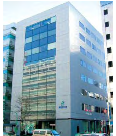
東亜合成本社ビル (アロンウオールリフレッシュ工法 RB-MS工法)
