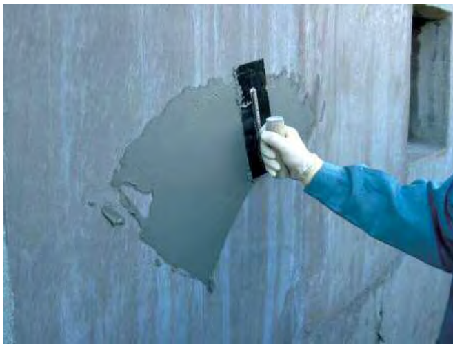
不陸調整作業(アロンカチオクリート)
