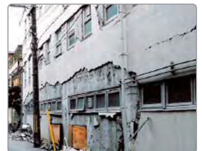
一般的な外壁の状況
