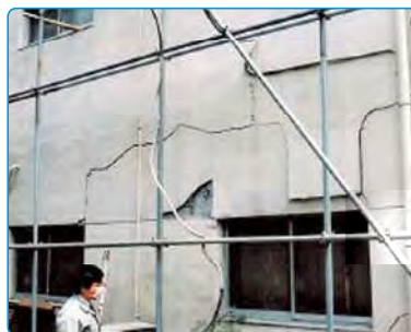
アロンウオール塗布外壁の状況
