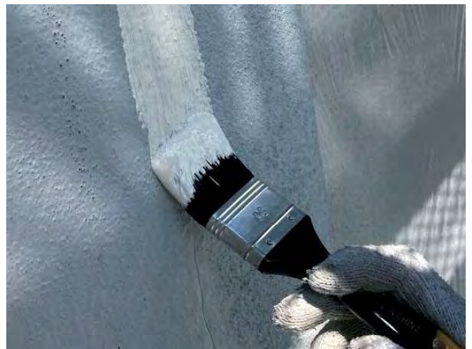
ひび割れ処理作業(アロンウオールSH)
