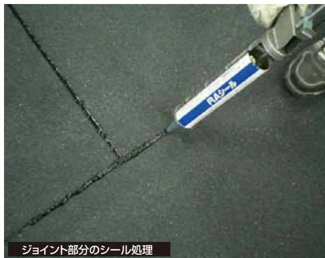
ジョイント部分のRAMシーラー塗布
